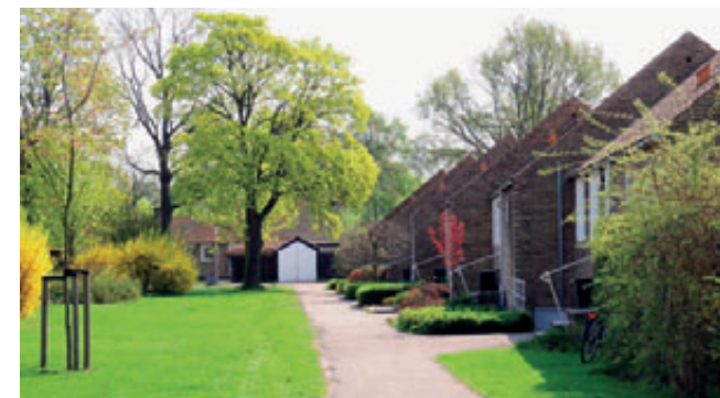
Forrest de forskudte rækkehuse set fra vest. Bag garagen ligger rækken med to enfamiliehuse ud mod grønningen
