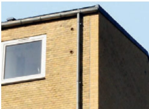
En ekstra muret gavl er tilføjet
