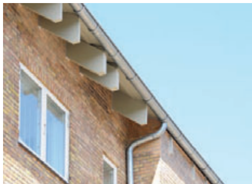
De nye spær titter frem på den forhøjede udbygning til højre
