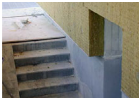
Fra den igangværende isolering af gavlene med isoleringspudskonstruktion
