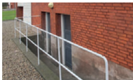
Kældernedgang med typisk rækværk
