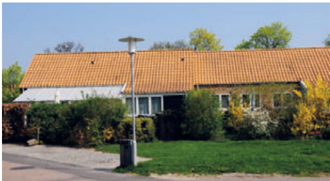
Nogle af rækkehusene har fået tilføjet overdækninger på terrassen
