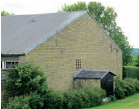
Lille teknikhus - kaldet hundehus - på gavlen af rækkehus. Den oprindelige tagdækning er bibeholdt
