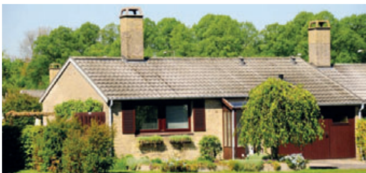
Gule rækkehuse med ændret tagbelægning. Oprindeligt opført med eternitskiffer
