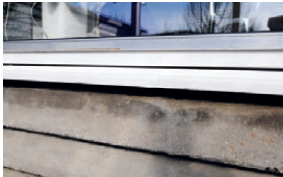
Detalje af vindue og betonbrystning
