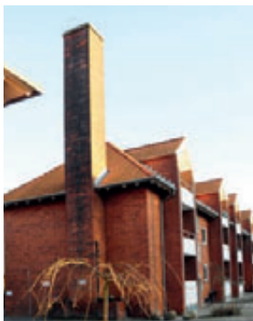
Skorsten på varmecentralen umiddelbart før nedrivningen
