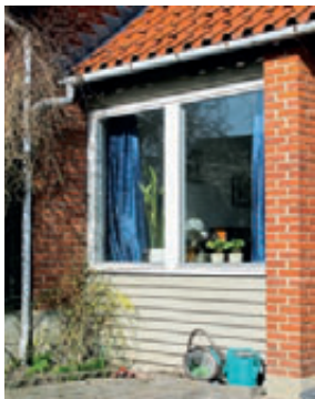
Vindue i opholdsstue med brystning i ubehandlet beton
