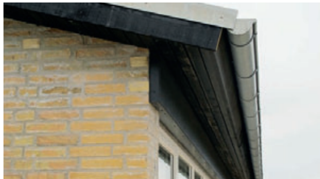
Tagkant med udhæng efter ombygningen (oprindeligt uden udhæng)
