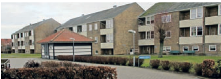
Bygningsfacader mod syd
