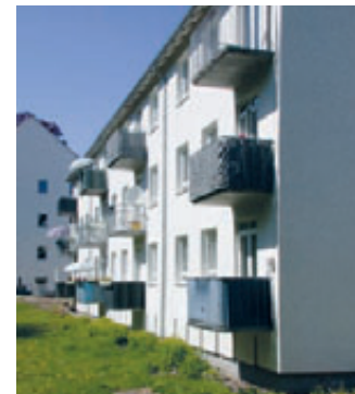
Sydfacade med udkragede altaner og karakteristiske tagudhæng og altaner
