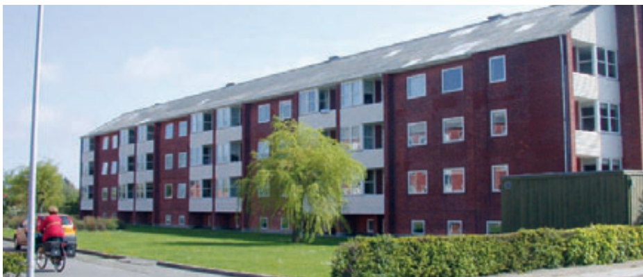
Fra den igangværende isolering af gavlene med isoleringspuds konstruktion
