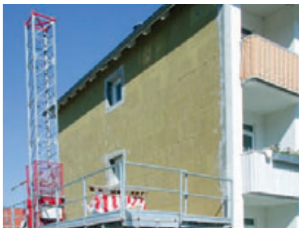
Fra den igangværende isolering af gavlene med isoleringspudskonstruktion
