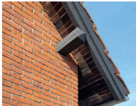
Gavl med udhæng
