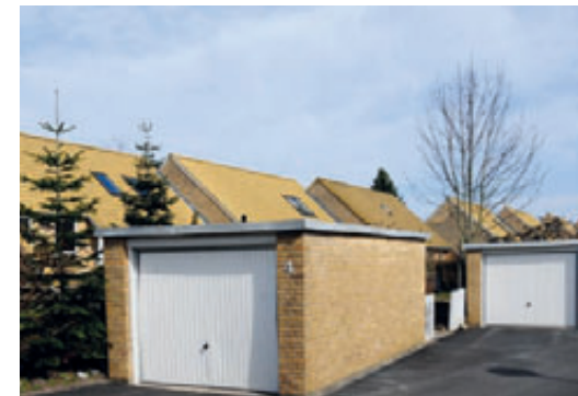
Enkelte garager er placeret i forbindelse med haver midt i byggeriet
