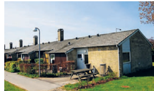
I nogle af rækkerne er der ud mod grøningen fællesfaciliteter som overnatningsværelser og vaskeri. Eller som her en billiardstue
