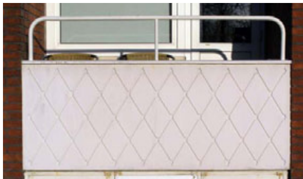
Brystning i beton støbt på stedet
