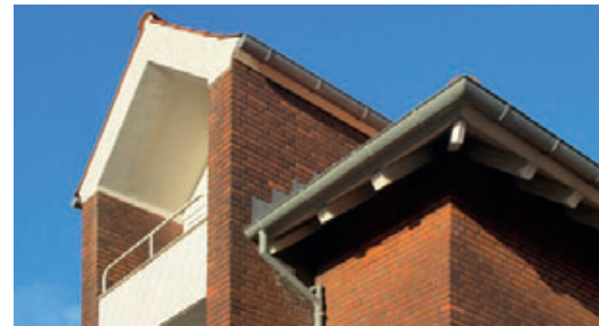
Typisk 50er tagkonstruktion med hvide spær og udhæng samt zinktagrender
