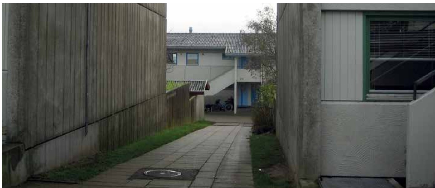
Boligafdelingen Sallingsundvej i Aalborg Øst 2010 – før renoveringen.
