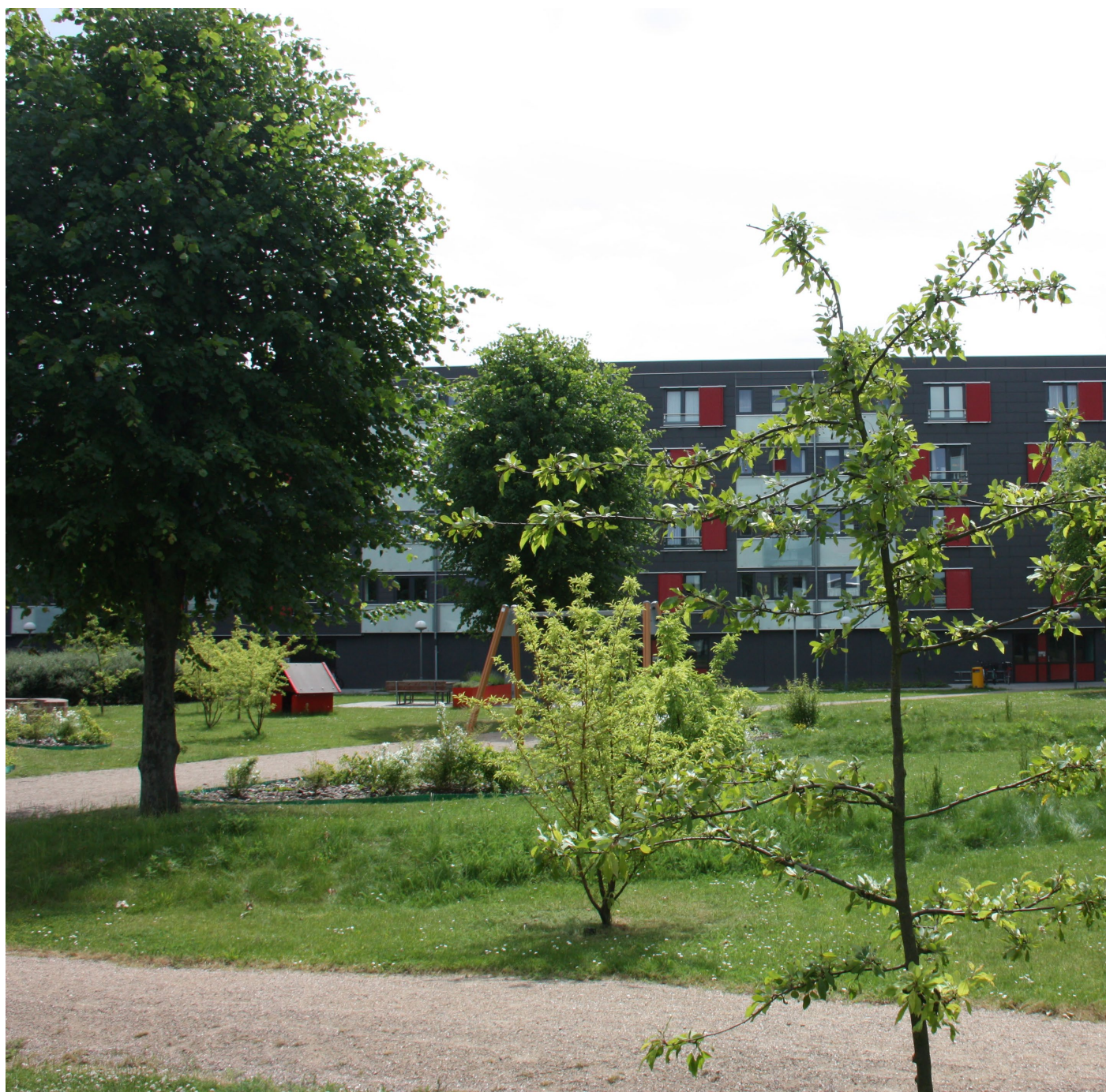
Eksisterende store træer er bevaret ved renovering og giver markant fylde i højden. (Remisevæget – 3B)
